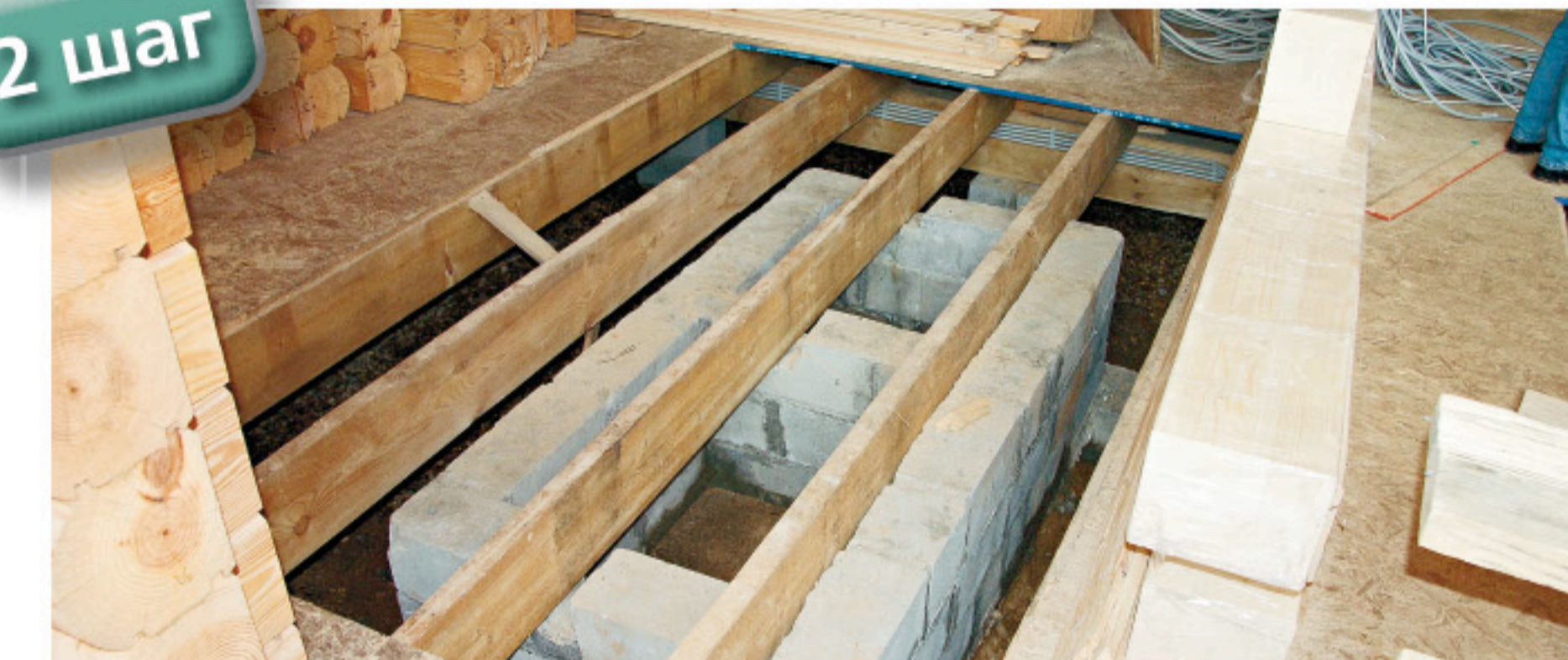
Лаги пола и фундамент под камин
